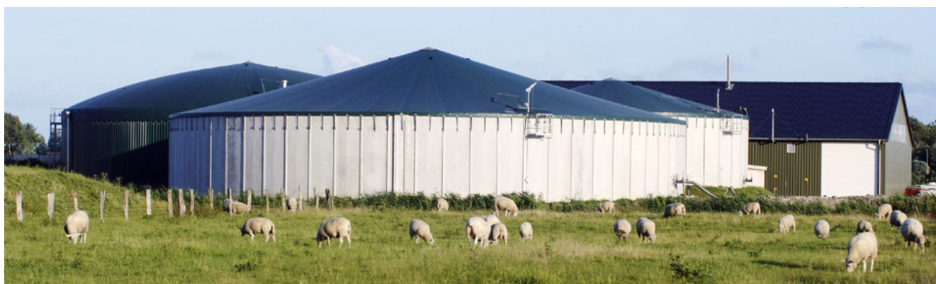
Usine de méthanisation des déchets agricoles ( www.envitec-biogaz.fr )
